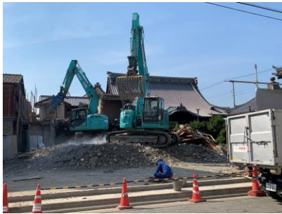
工事の様子。道路側より進行。本堂は通常どおり開放しております。
